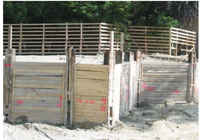
Abbildung 3: Berliner Verbau und Baumschutzzaun
