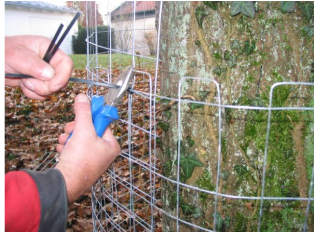
Abb. 6 Zuschneiden der Matten und Binder
