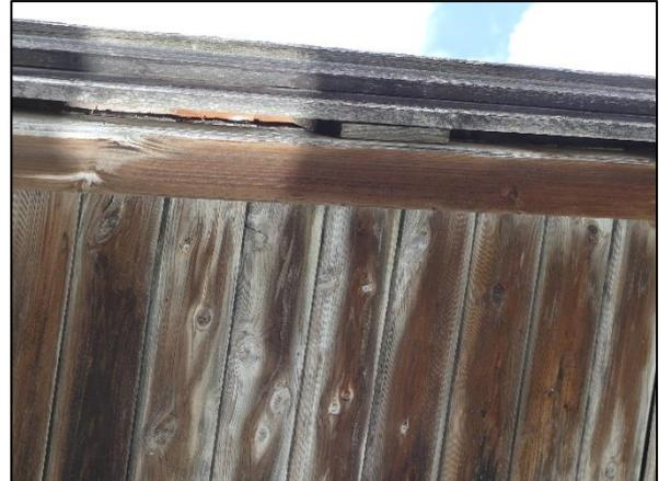
Bild 02: Detail des mit Spiegel ausgeleuchteten Giebelbrettes auf der Südseite der Brennerei (Spalt etwas zu breit für optimale Eignung)
