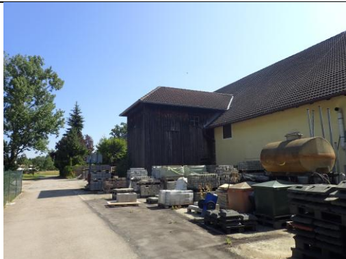
Abbildung 12: Blick auf Rückseite des Gebäudes mit Werkstatt und Lager Quelle: Aufnahme (PV München, Juli 2023)
