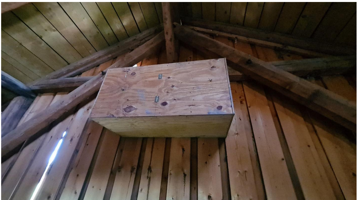
Abb. 21: Turmfalken-Nistkastens im Bereich der östlichen Fassade des südlichen Hauptgebäudes.
