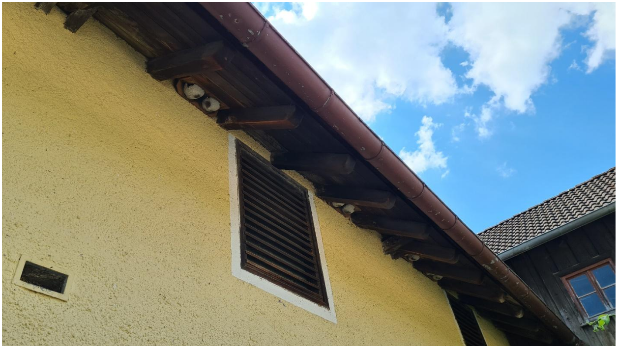
Abb. 12: Westliche Fassade des westlichen Hauptgebäudes mit künstlichen Nisthilfen für die Mehlschwalbe.
