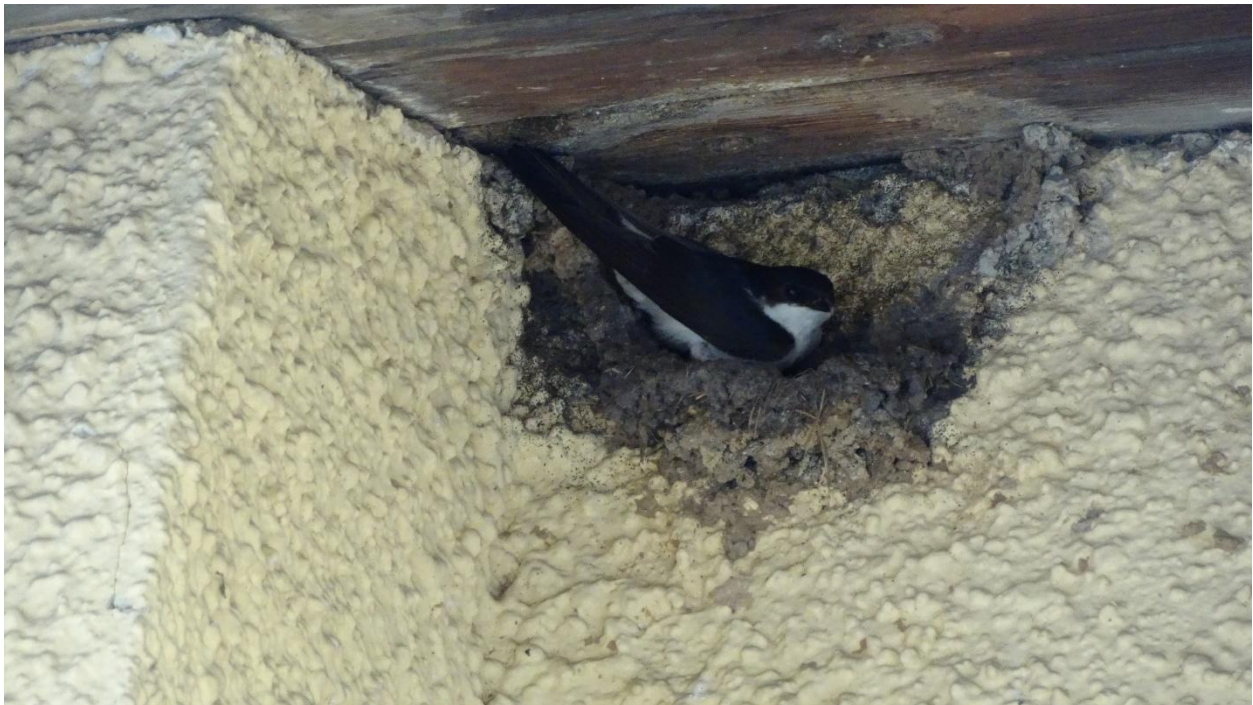
Abb. 14: Brutversuch einer Mehlschwalbe an der südlichen Fassade des südlichen Hauptgebäudes im Juli 2024.
