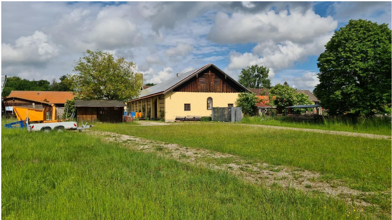
Abb. 7: Bauhofgelände von Südosten aus gesehen mit Lager- bzw. Grünfläche im Vordergrund.
