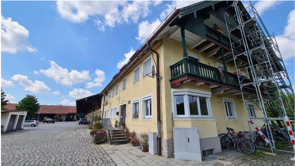
Abb. 5: Westliches Hauptgebäude des Bauhofs mit als Wohngebäude genutztem, nördlichen Teil im Vordergrund.
